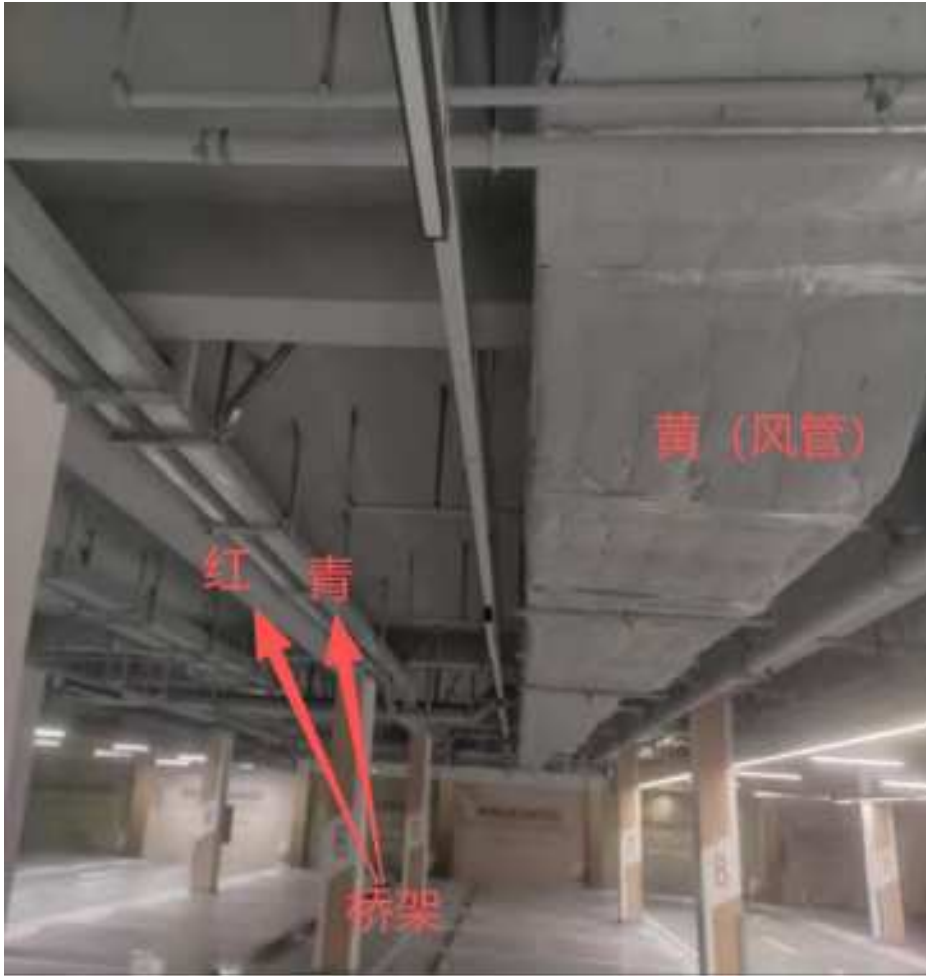
5号楼负一层前车位地下室消防管、桥架、风管施工/模型对比图 2
