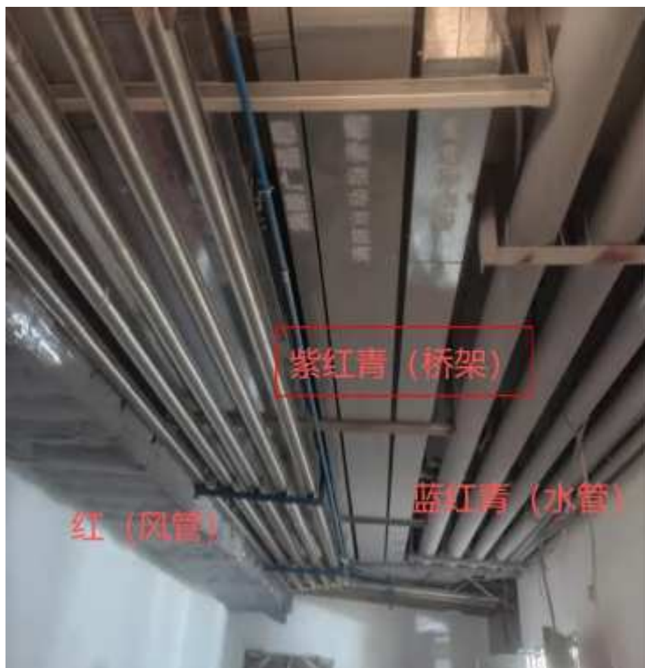
6号楼负一层电梯前室地下室消防水管、桥架施工/模型对比图 5
