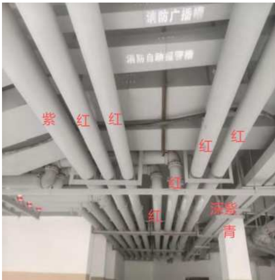
5 号楼负一层配电小间前地下室消防水管、桥架施工/模型对比图 1
