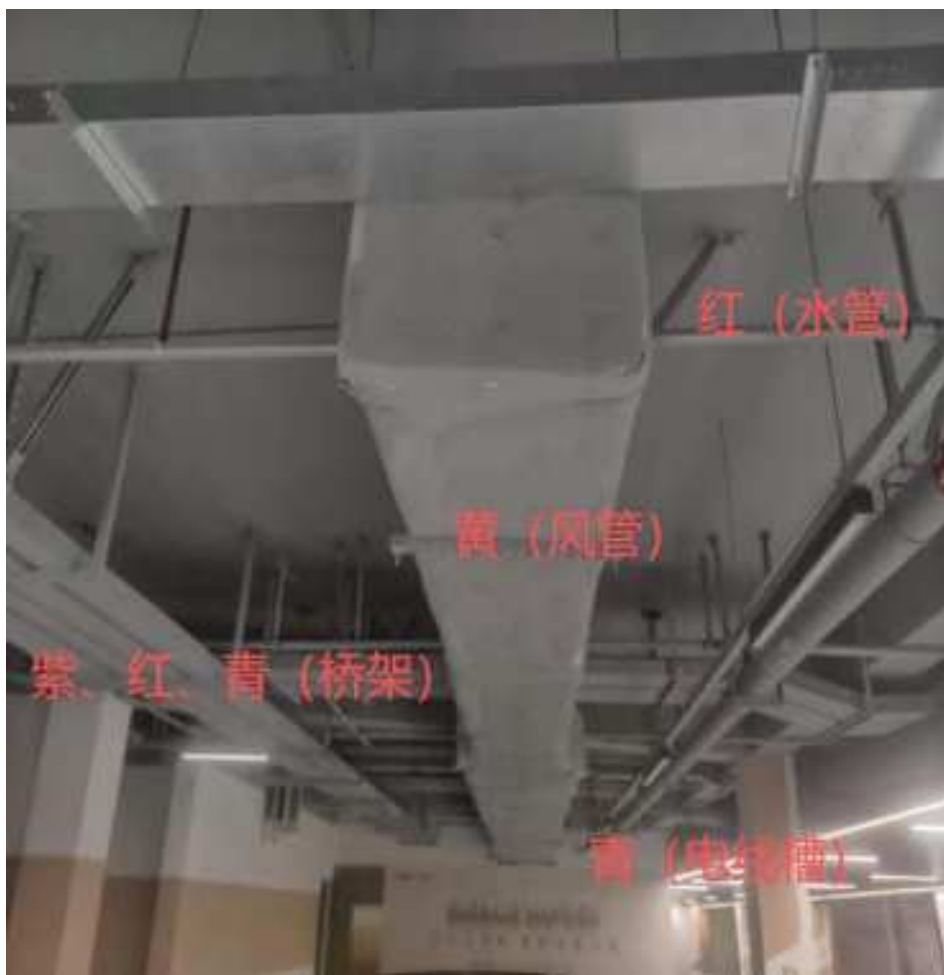
17 号楼负一层前车位地下室消防管、桥架、风管施工/模型对比图 3
